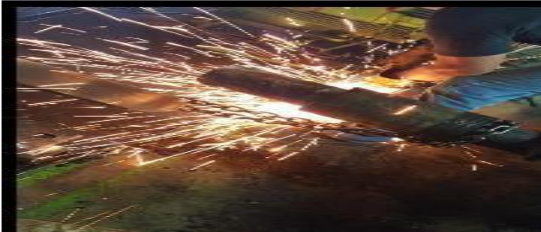
Figura 11.20. Ensamble de usillo nuevo.
