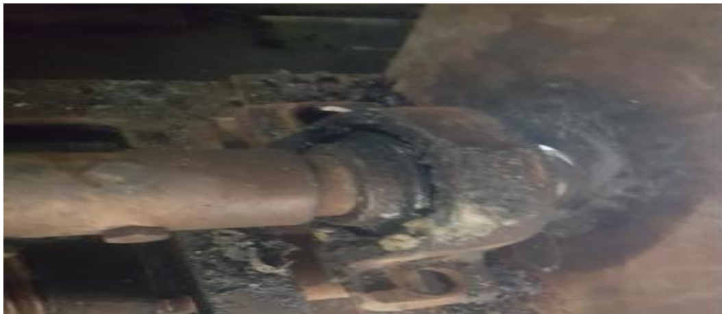
Figura 11.7. Cambio de chumacera en mal estado.
